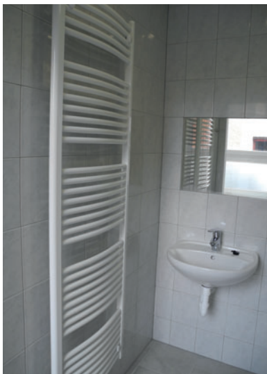
Rekonstrukce sociálních zařízení v sokolovně
